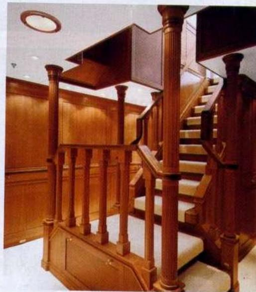
**Sopra, la scala principale che conduce in coperta realizzata con elementi di legno a forma di colonna con funzione strutturale.**
